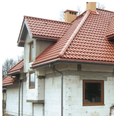
Nosivi zidovu u kućama
