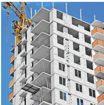
Obodni zidovi u zgradama
